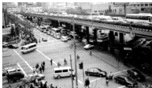
图 1 上海市内环线武宁路下匝道处的交通情况: 下匝道车辆排成长队, 交通处于拥堵状态; 相交道路上右转车辆连绵不断。 (拍摄时间: 2002 年 4 月 24 日)
