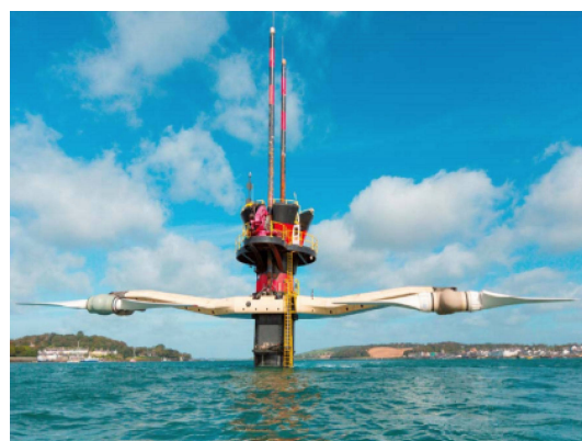
图3 SeaGen 型 1.2 MW 潮流能发电装置 [4]
